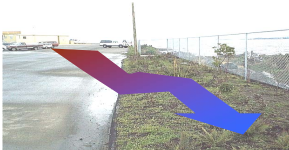
Ci-dessus : rigole de drainage «Biofiltre»
