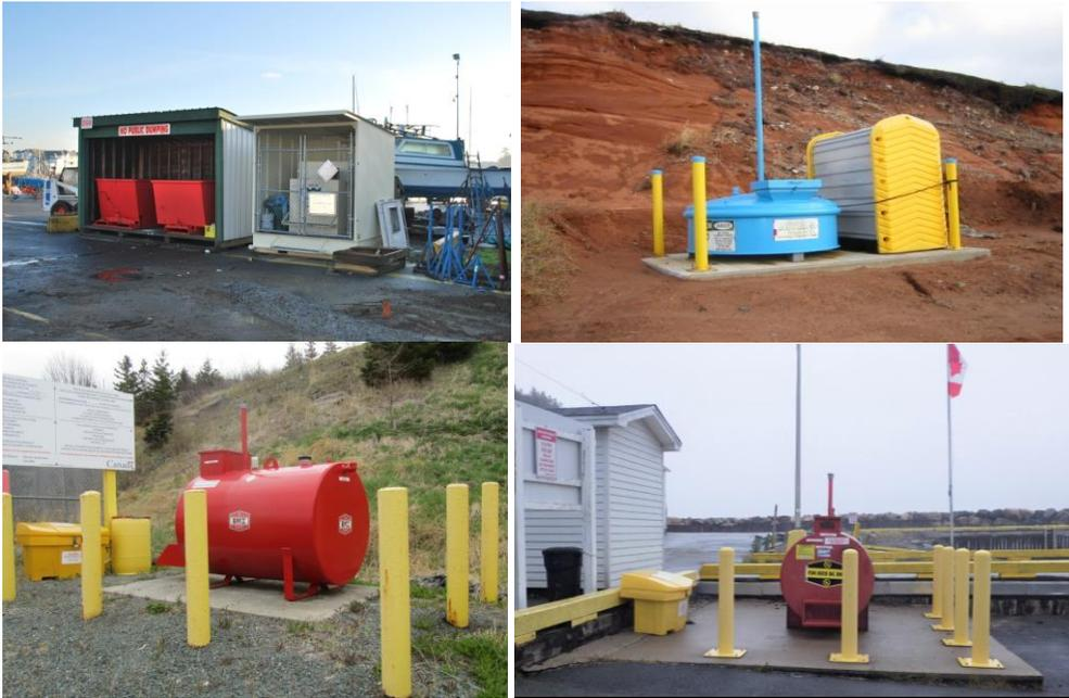
Ces images représentent des exemples de réservoirs d'huiles usées installés à l'extérieur avec protection adéquate contre les chocs potentiels des véhicules (clôture, bornes).
