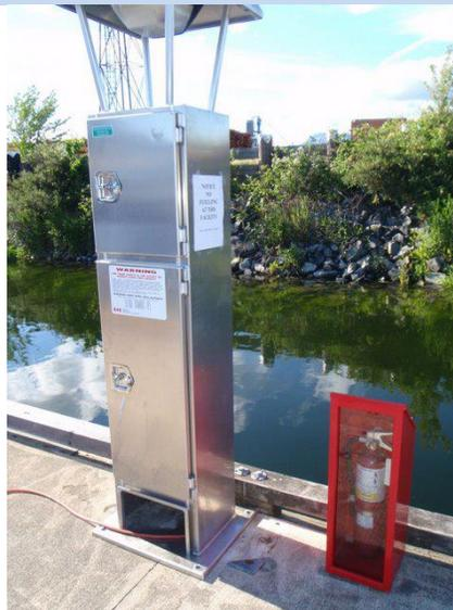
Distribution par prise de courant avec disjoncteurs et luminaires combinés.
