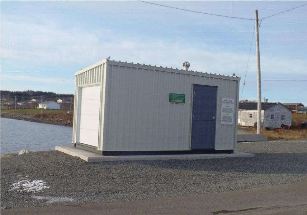
Exemple de bâtiment spécialement conçu pour abriter des réservoirs d'huiles usées, avec une ventilation adéquate et un système de confinement des déversements au sol.
